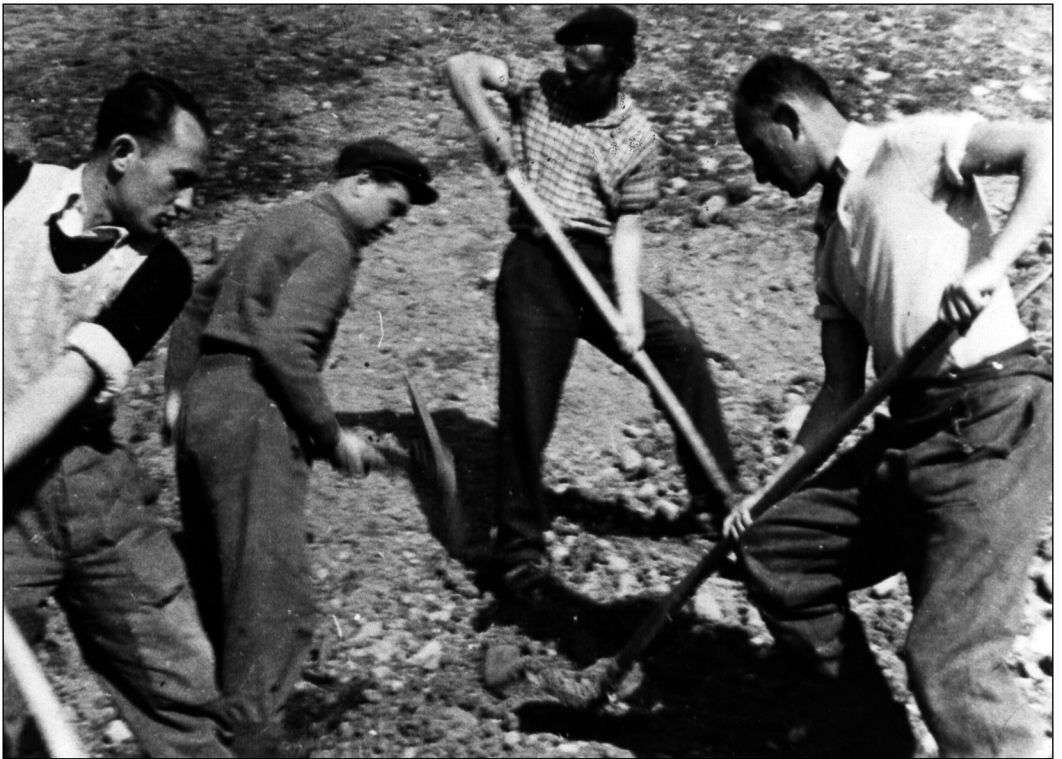
Beim Straßenbau im Arbeitslager Geisshof (Schweiz) ca. 1940/41 (r. LK, 2.v.l. Kurt Seliger)
